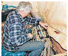
Die Leitungen muss per Hand „angeschlossen“ werden. FOTO: SEBASTIAN
