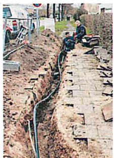
Andy Steinau und Harald Jonng von der Firma Infra-Tec reparieren die beschädigte Stromleitung. FOTO: SEBASTIAN
